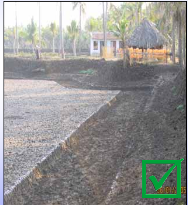
Persiapan tambak yang baik
